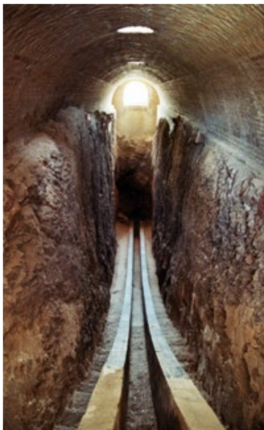
◀ Шахта с частью гигантского мраморного стенового квадранта (секстанта), точно ориентированного по меридиану. С помощью этого астрономического инструмента производились измерения координат звезд и планет
